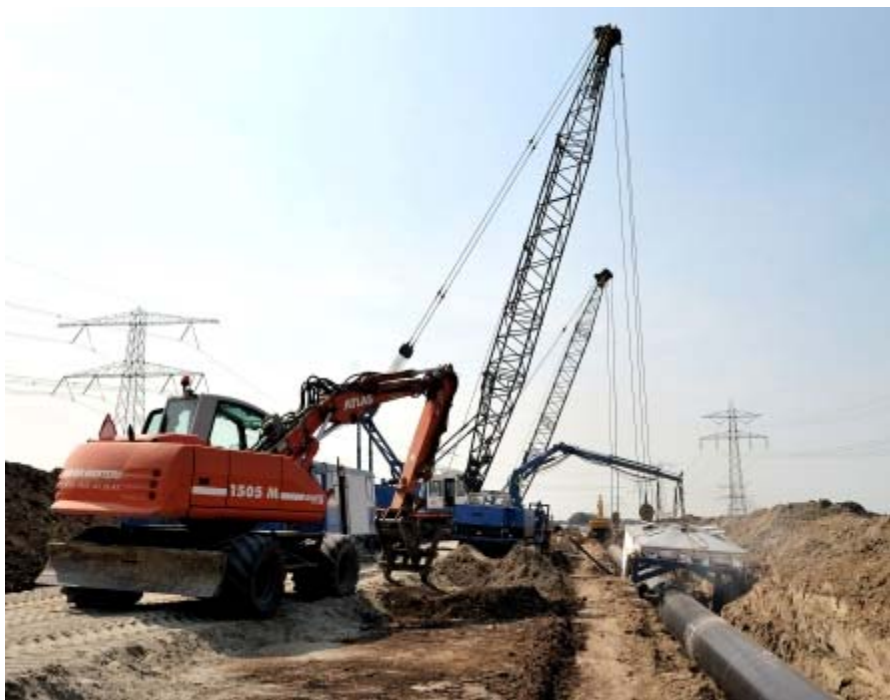
het verleggen van waterleidingen door open ontgravingen
