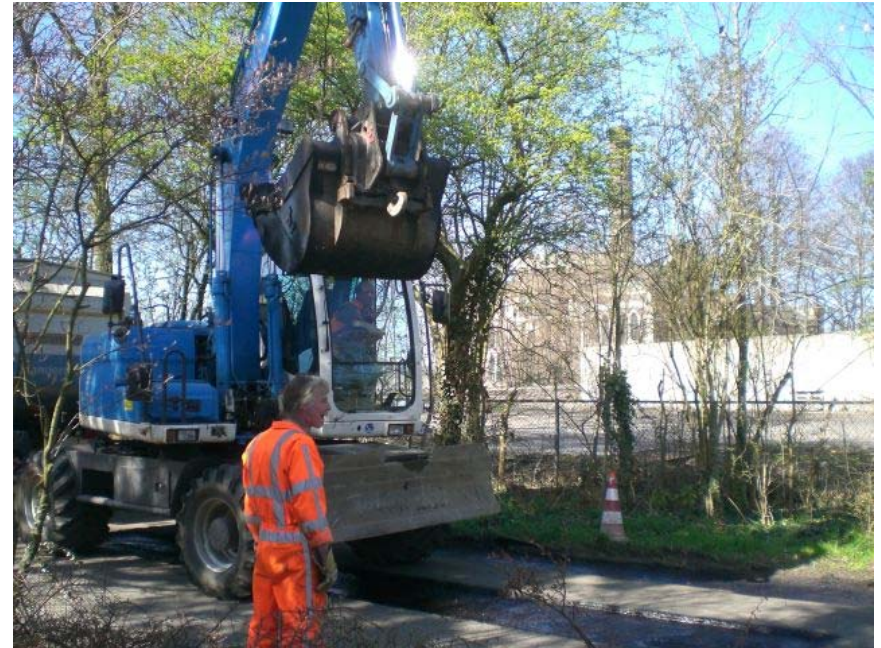
Ter hoogte van het gemaal werd het asfalt bijgewerkt.
