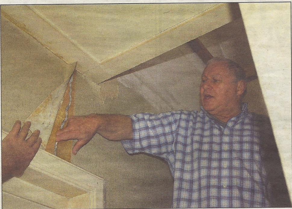
Wim Balvers toont een van de vele scheuren in zijn huis als gevolg van zwaar verkeer.
